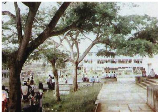
Avant la rénovation 1969 – 2002
